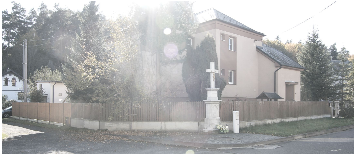
Fotodokumentace stávajícího stavu
