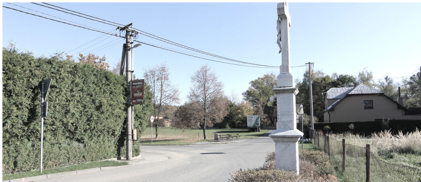
Fotodokumentace stávajícího stavu
