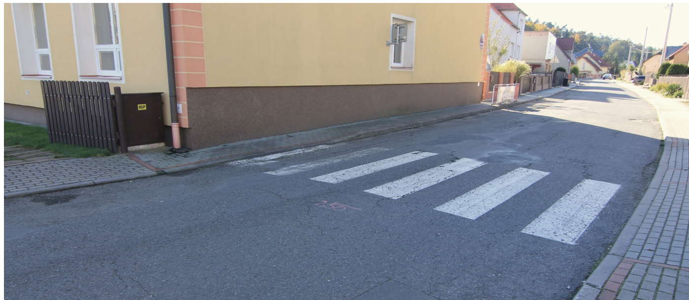
Fotodokumentace stávajícího stavu
