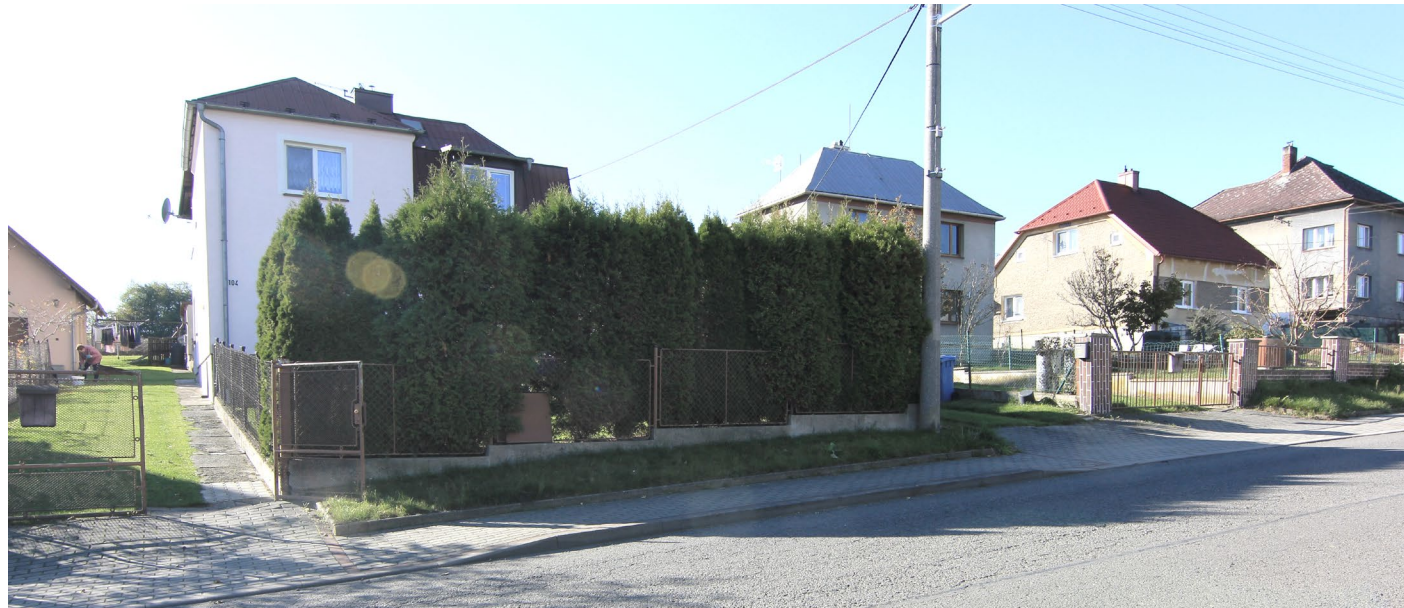
Fotodokumentace stávajícího stavu
