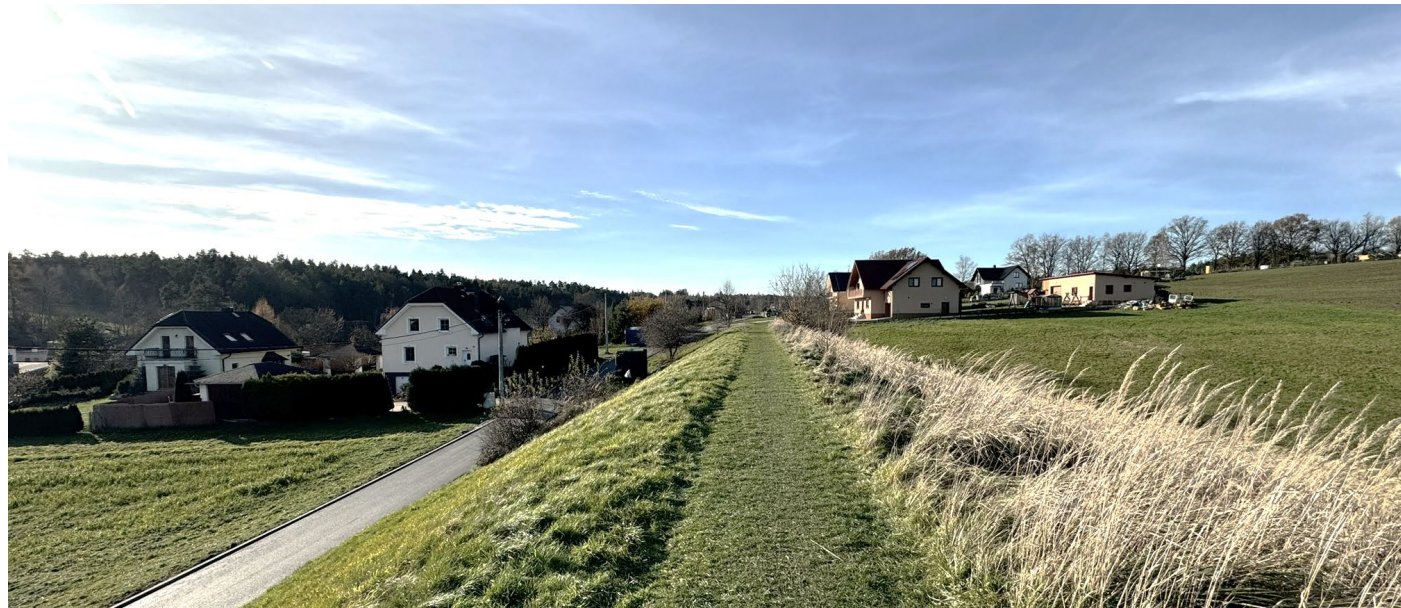
Fotodokumentace stávajícího stavu
