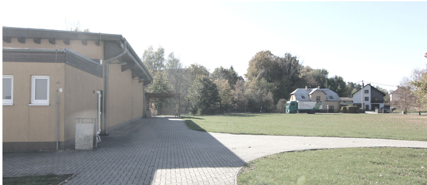
Fotodokumentace stávajícího stavu
