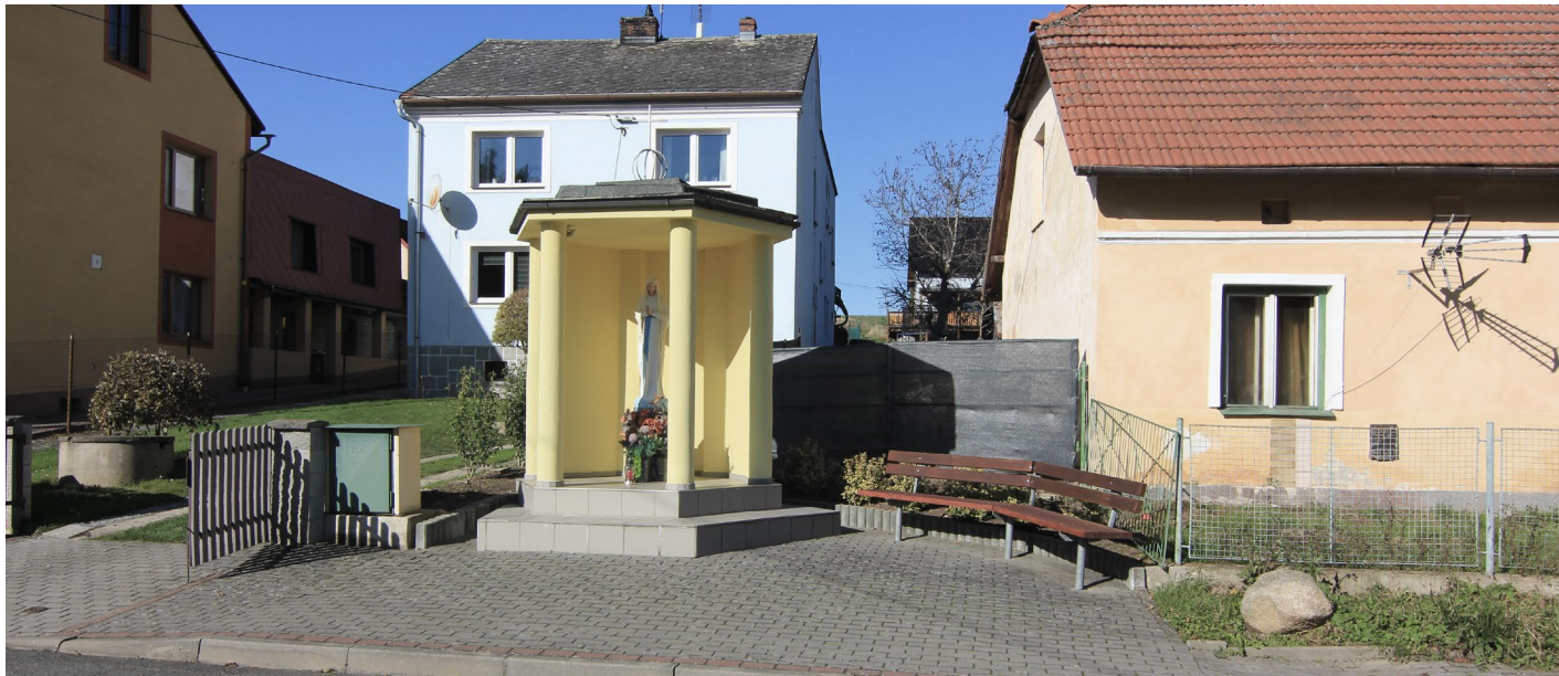
Fotodokumentace stávajícího stavu
