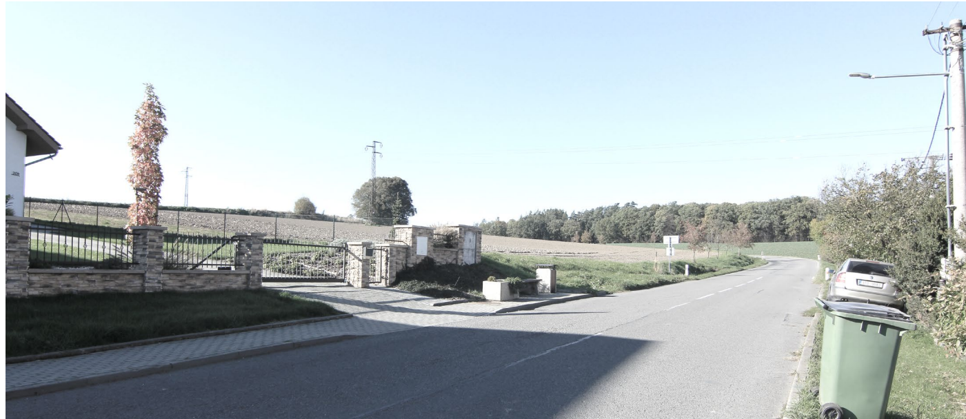
Fotodokumentace stávajícího stavu
